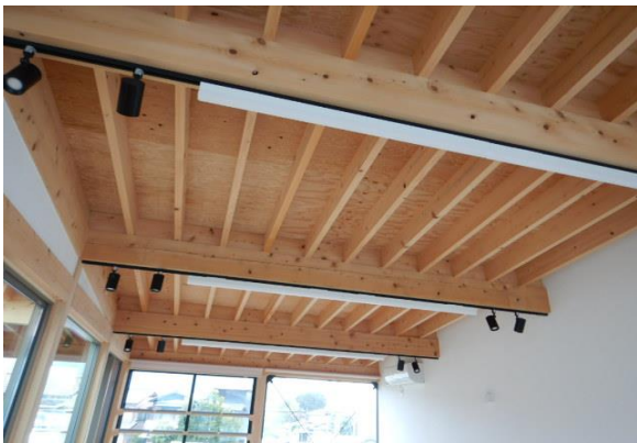
施設2階 内側(拡大)
